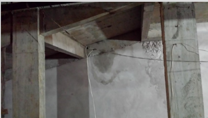
Figura 4.31 – Fios do circuito de iluminação
