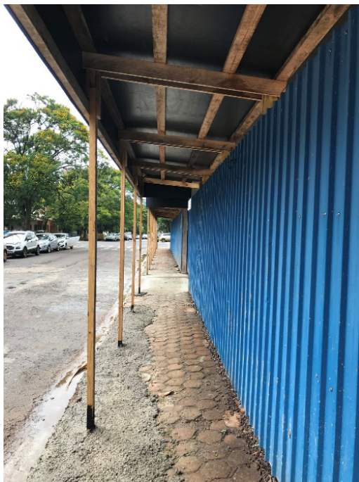
Figura 1.12 – Galeria sobre passeio público
