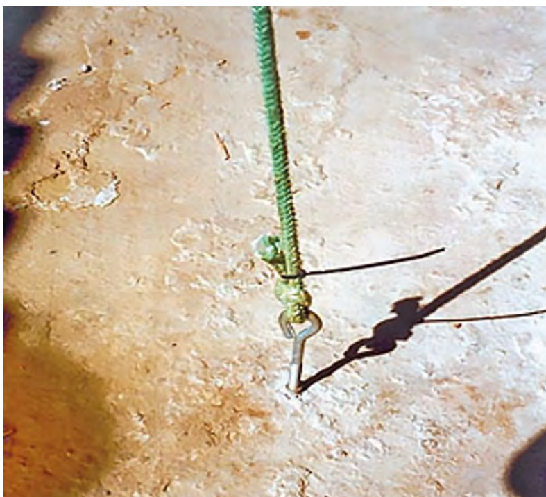
Figura 3.34 – Tensionamento da tela fachadeira por meio de cordas
