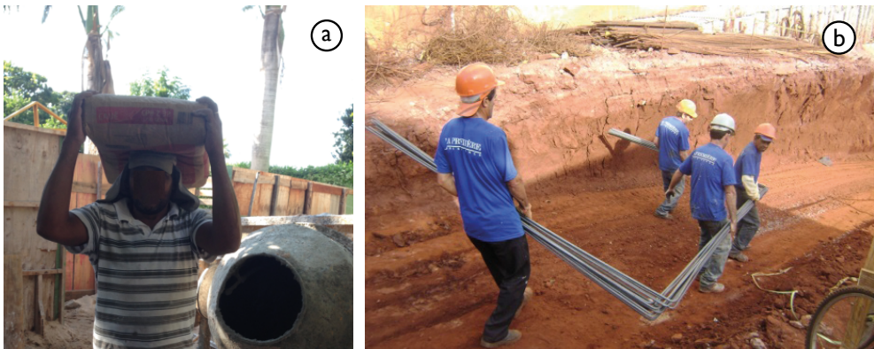
Figura 6.8 – Transporte e manuseio de cargas
