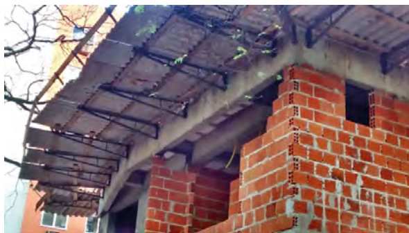
Figura 3.1 – Utilização de telhas de fibrocimento para plataforma de proteção
