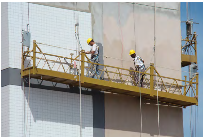
Figura 3.42 – Linha de vida vertical para fixação de cinto de funcionários na realização de trabalhos em fachada de edificação sobre andamento suspenso (balancim)
