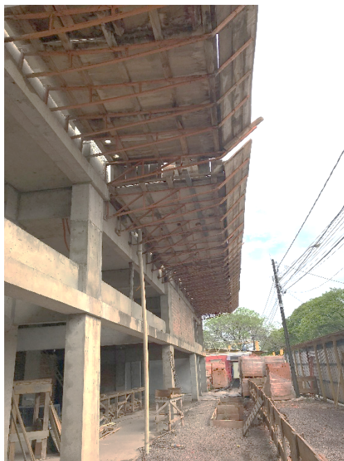
Figura 3.26 – Estrutura metálica e sarrafos de madeira
