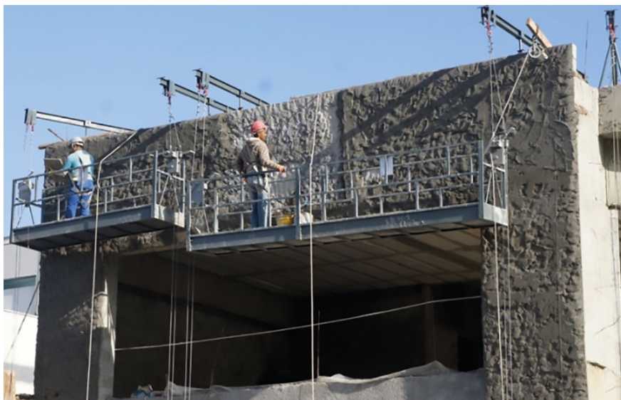
Figura 1.1 – Andaimes suspensos fixados na estrutura da edificação com emprego de vigas metálicas com perfil I e cabos de aço
