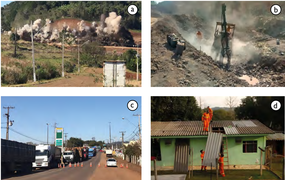
Figura 5.1 – Atividade de desmorte de rocha; (a) Desmorte com uso de explosivos; (b) Desmorte com o uso de perfuratriz; (c) Interdição do fluxo durante o desmorte com explosivos. (d) Reparo de danos causados a vizinhança devido a fragmentos rochosos
