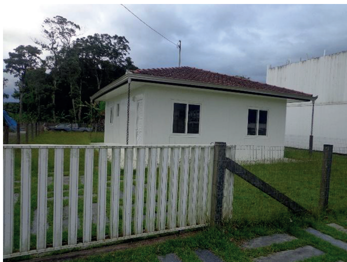
Figura 5 – Protótipo – Casa em concreto-PVC. Fonte: Autores (2016).
