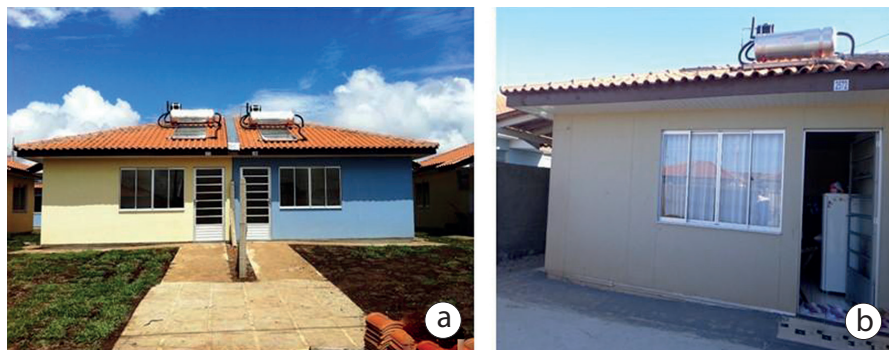
Figura 10. Conjunto habitacional em uso. (a) Vista das unidades habitacionais geminadas; (b) detalhe da fachada, cobertura/beiral e painel/esquadrias. Fonte: Autores (2016).
