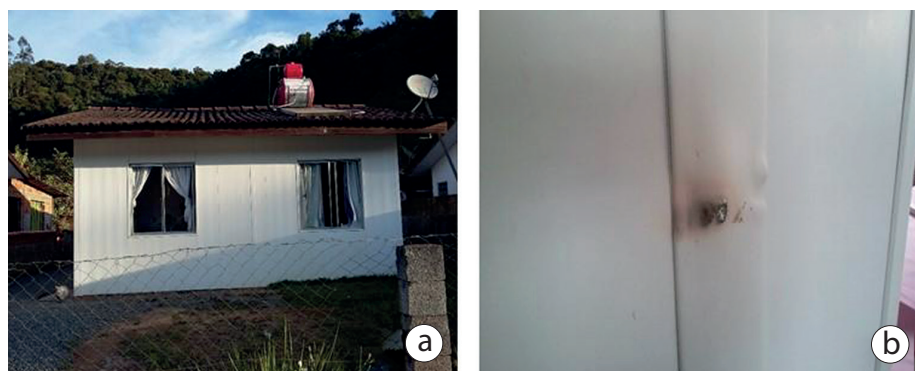
Figura 7. Conjunto habitacional em uso. (a) Vista da unidade habitacional; (b) Painel de PVC e princípio de incêndio sem propagação do fogo. Fonte: Autores (2016).
