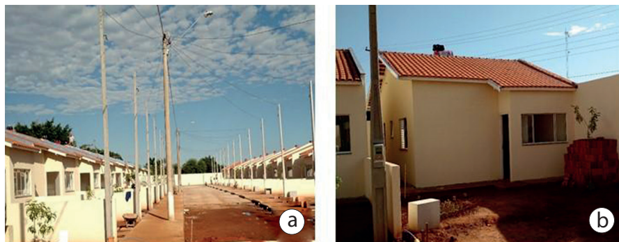
Figura 2. Conjunto habitacional em execução com painéis pré-moldados mistos. (a) Vista frontal das fachadas; (b) Tipologia da unidade padrão. Fonte: Autores (2016).
