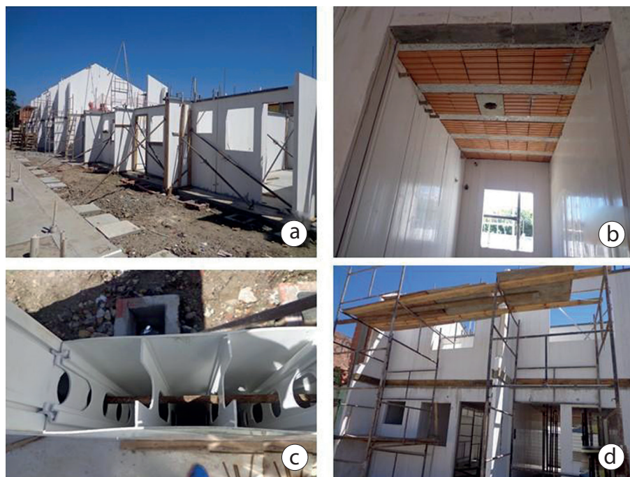
Figura 6. Conjunto habitacional em execução de painéis de PVC e concreto. (a) Montagem do primeiro pavimento; (b) laje pré-fabricada; (c) detalhe do interior dos perfis e passagem de armaduras; (d) Montagem do segundo pavimento. Fonte: Autores (2016).
