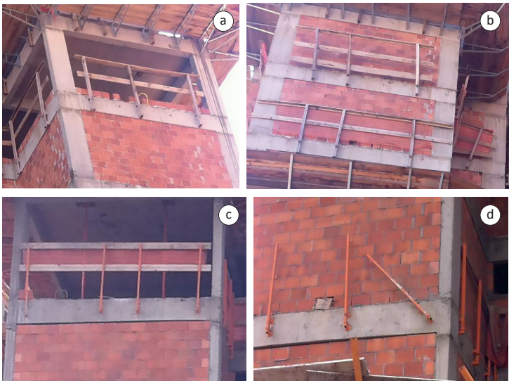
Figura 6 – (a) Remoção do SPP-MA-1 antes da vedação vertical; (b) SPP-MA-1 após vedação vertical; (c) remoção do SPP-MI-5 antes da vedação vertical; e (d) SPP- MI-5 após vedação vertical. Fonte: Peñaloza, 2015.
