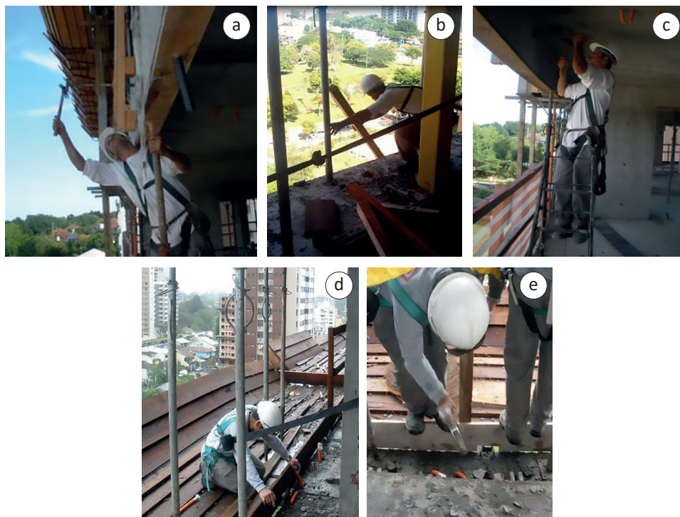
Figura 2 – Exemplo de atendimento parcial ao requisito 5 - montagem SPP-MA-1. Fonte: Peñaloza, 2015.
